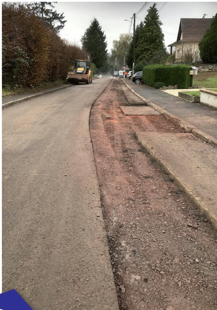
La rue a été coupée au démarrage des travaux de rénovation de la conduite principale d'eau potable le 2 août 2021, pour un planning prévisionnel de 4 mois de travaux. Les ruptures à répétition ont justifié le remplacement de l'ancienne conduite datant des années 1945/50.
