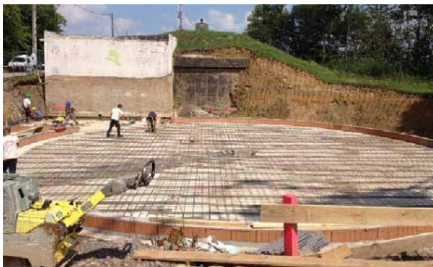
La construction de la 2 e cuve du réservoir du Hochwald
