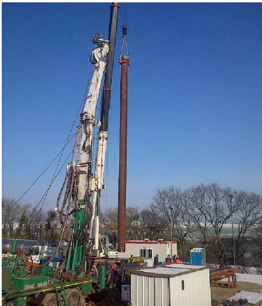
Le site du nouveau forage à Oermingen
