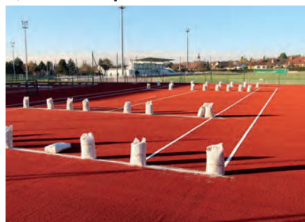
Les travaux sur les courts de tennis extérieurs
