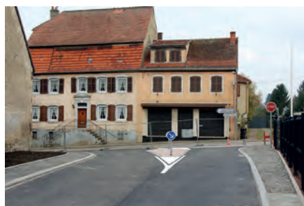
Les travaux de voirie rue Max Karcher
