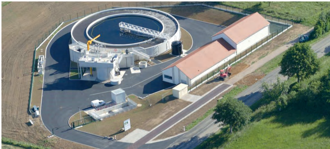
Une vue aérienne de la nouvelle station d'épuration
