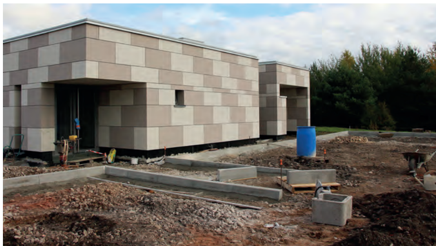
Le funérarium en construction
