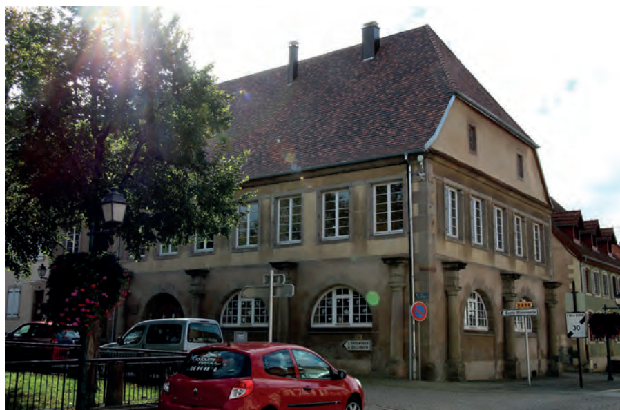
La toiture rénovée au 1, rue de l'école
